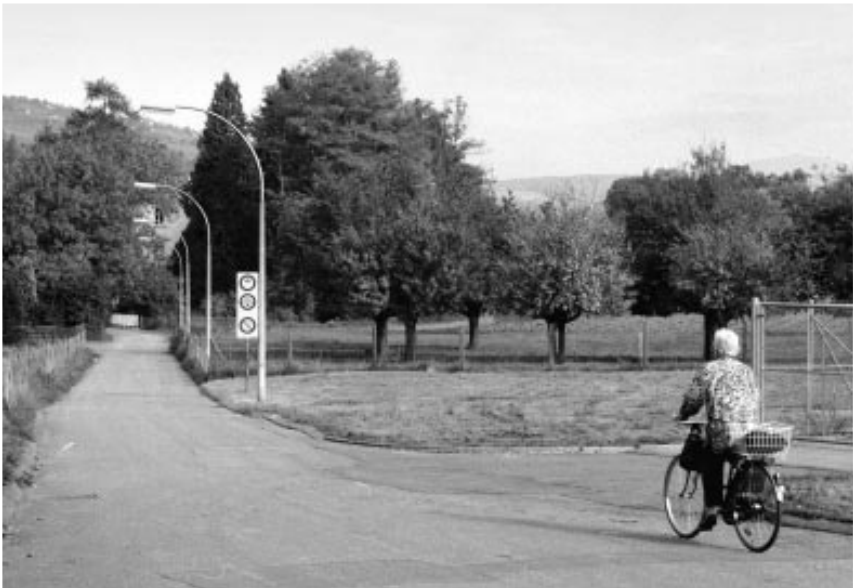
Vom Kehrplatz bei der Einfahrt zum Bachtelenweg bis zur Bohrstelle der Geothermieranlage (am rechten Bildrand sichtbar) werden bis Ende Dezember abgesetzte Bordsteine verlegt sowie ein Teerbelag aufgezogen.
