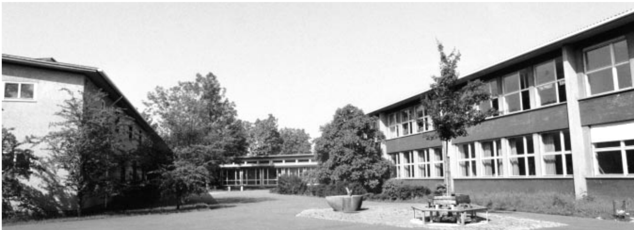
Die Gaskesselanlage im alten Teil des Hebelschulhauses – unser Archivbild stammt aus der Zeit vor dem Bau des neuen Schulhauspavillons – ist sanierungsbedürftig. Allenfalls kann sie künftig noch als Spitzenlastkessel dienen. Foto: RZ-Archiv
