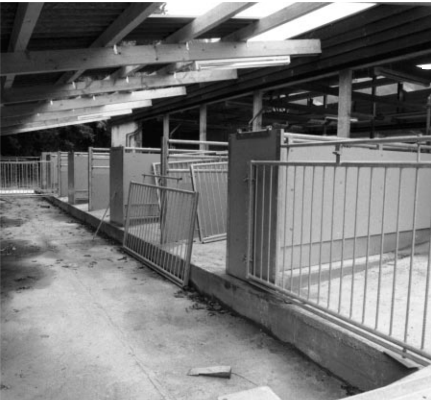
Ein Blick in den neuen Schweinestall, der zusammen mit einem neuen Rinderstall beim Maienbühlhof in Bau ist.
