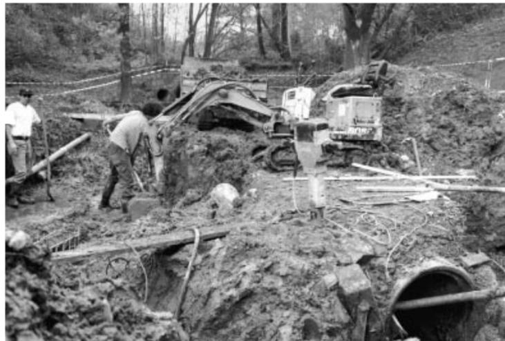
In harter Arbeit wird der Aubach von seinem engen Korsett, einer Betonröhre, befreit und soll wieder frei fließen können.
