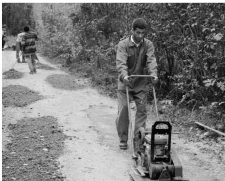
Wegsanierung im Rieherer Wald: auf den ausgeschwemmten Lamperstalweg wird Mergel aus der Sissacher Grüssi-Grube aufgetragen und flachgewalzt.
