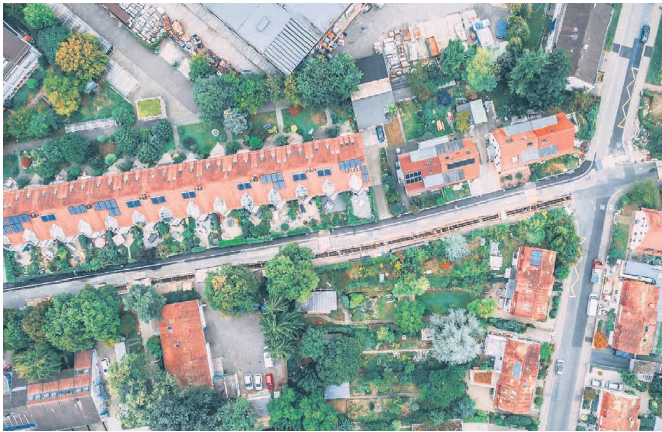
Neu verlegte Versorgungsleitung der Wärmeverbund Riehen AG im Blutrainweg.
