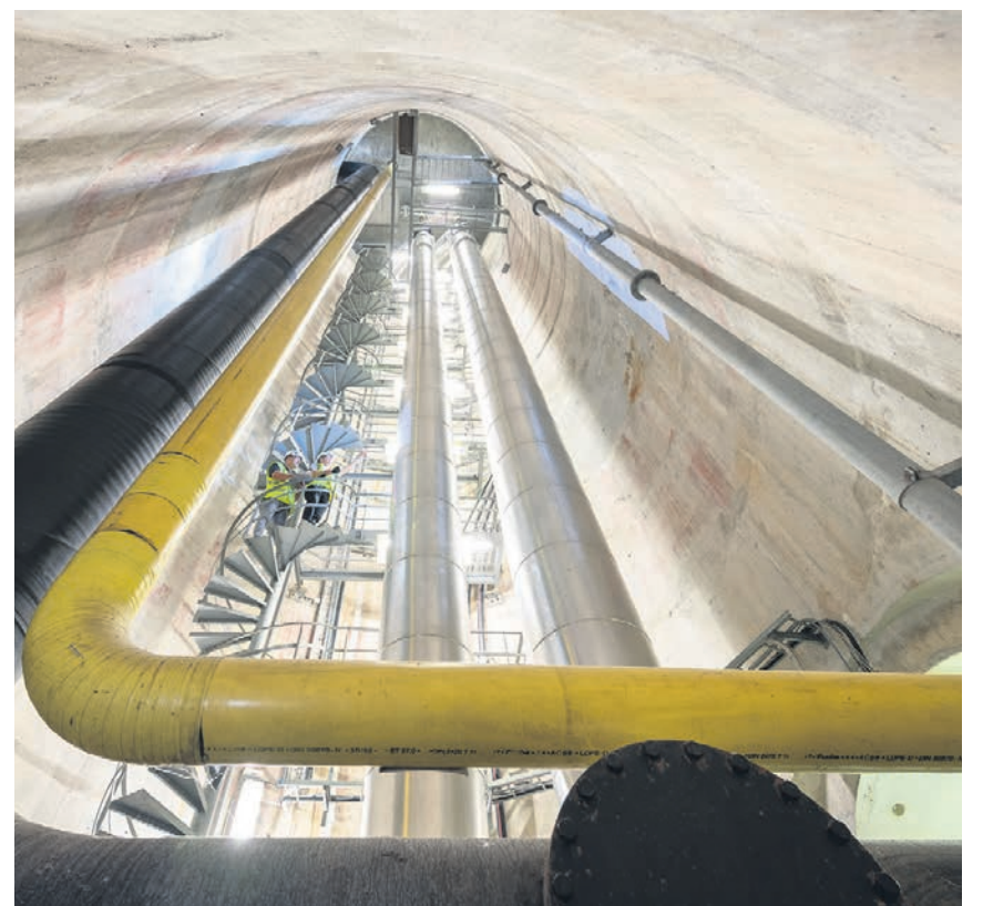
Im Basler Rheindüker unterqueren Versorgungsleitungen den Rhein.
