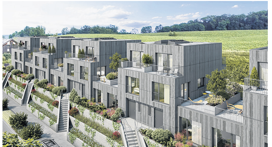
Die Siedlung an der Inzlingerstrasse 319 in Riehen, die Architektur stammt von Ansgar Staudt Architekten SIA GmbH.
