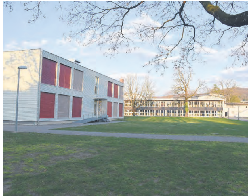
Zwischen dem schon bestehenden Provisorium und der Sporthalle Niederholz soll ein zweites Provisorium mehr Schulraum schaffen.
