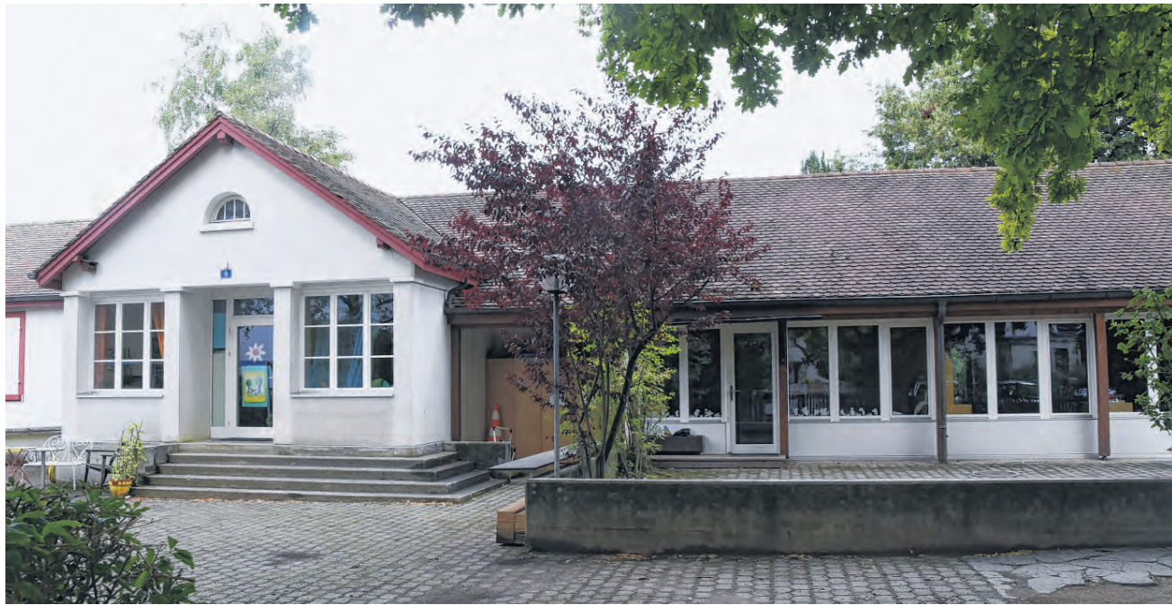
Der Doppelkindergarten Siegwaldweg soll demnächst durch einen Neubau ersetzt werden.
