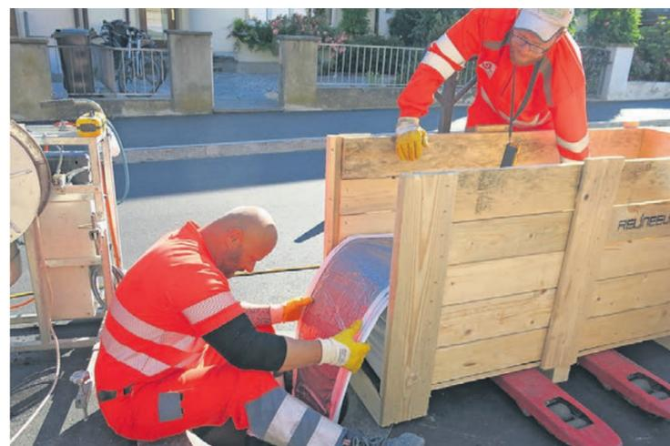
Der Schlauchliner wird in den Schacht hinuntergelassen. Dort sorgt ein weiterer Kanaltechniker dafür, dass der Liner durch das alte Rohr befördert wird.
