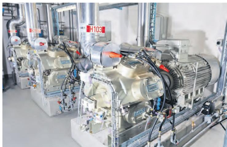
Technik der Geothermieanlage: der Verdichter in der Heizzentrale am Haselrain. Fotos: zVg
