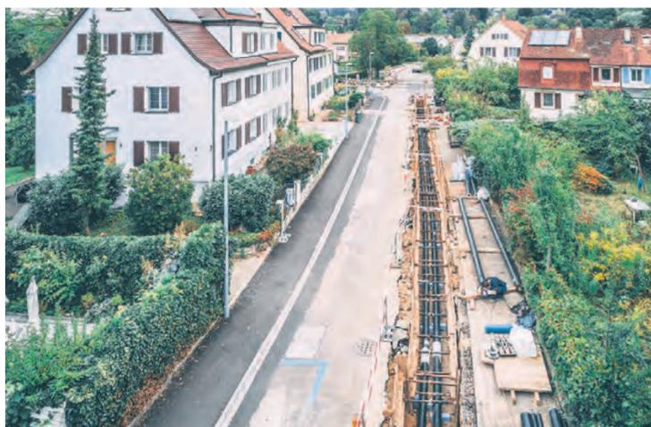
Der Blutrainweg während des Einbaus der Geothermieleitungen im Zuge der Netzerweiterungen im Niederholzquartier.
