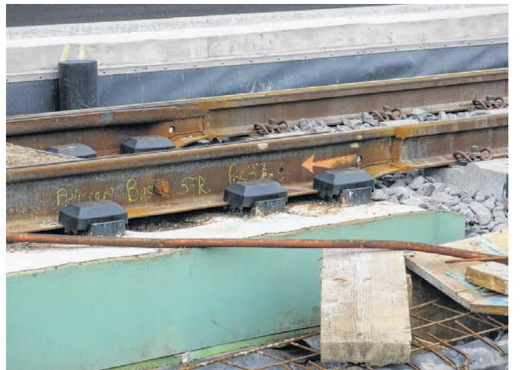
Der Gleisoberbau gestaltet sich nicht in allen Abschnitten gleich: Während die Gleise links auf einer Betonplatte liegen, sind sie rechts (ganz aussen) auf einem Schotterbett platziert.
