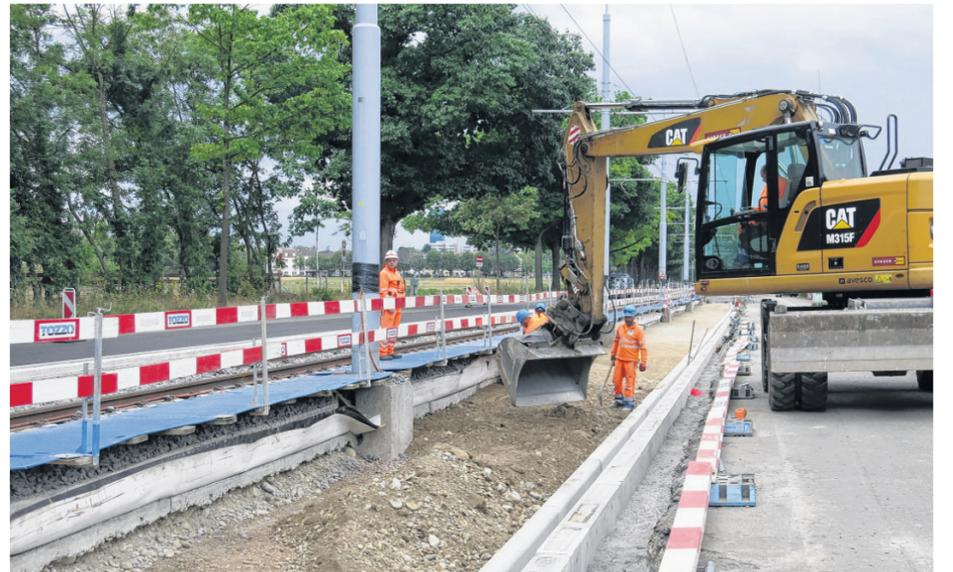
Erst wenn die Abdichtung und die Schutzschicht auf der Grundwasserschutzwanne platziert ist, kann der Schotter aufgeschüttet und das Gleis eingebaut werden.
