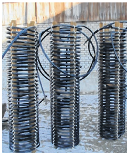
Erdkörbe vor dem Einbau, während dem Einbau und nach dem Einbau.
