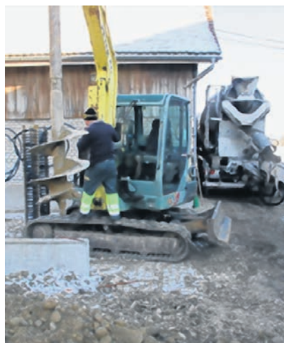
Erdkörbe vor dem Einbau, während dem Einbau und nach dem Einbau.
