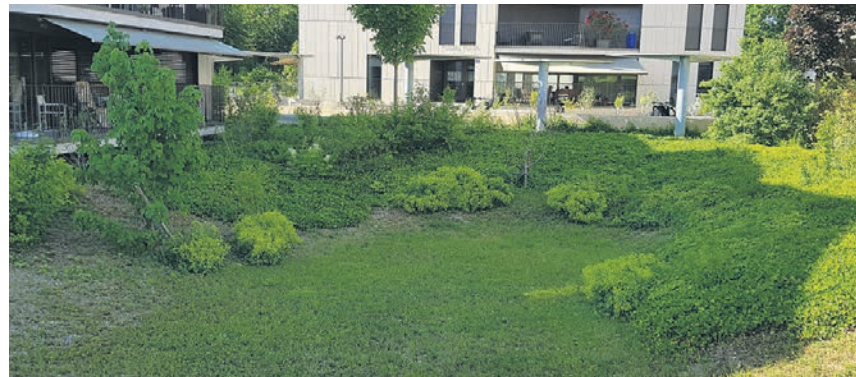
Versickerungsanlage (Typ A) am Kohlistieg, bei der das Regenwasser über die belebte Bodenschicht ins Grundwasser infiltriert.
