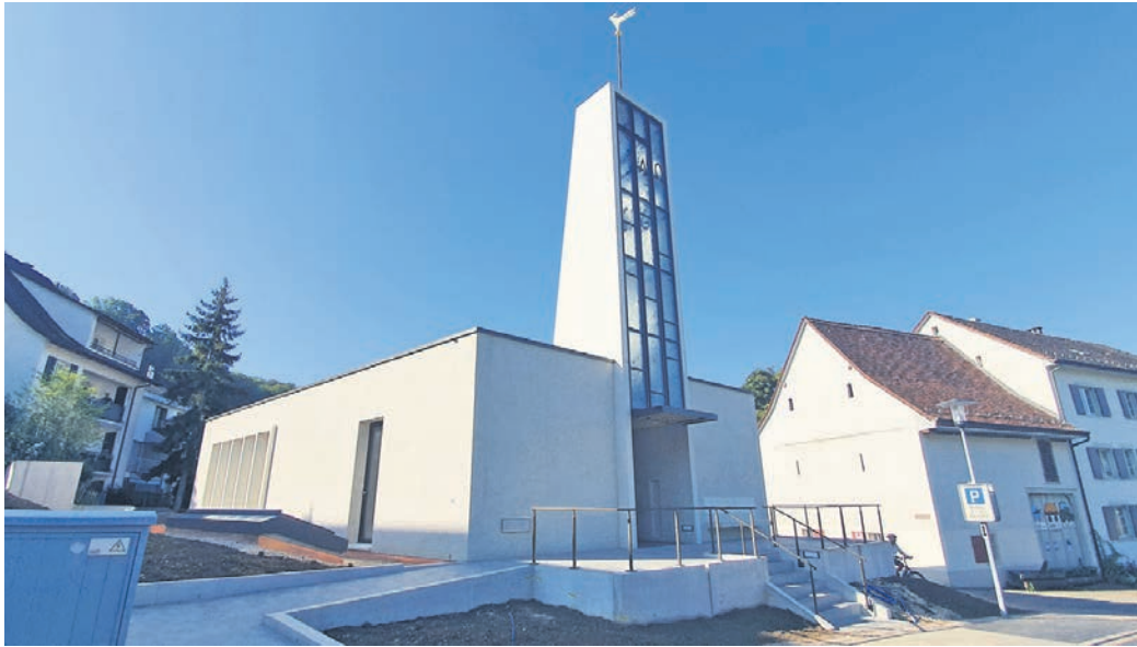
Sie ist so gut wie fertig und wird am 14. November eröffnet: die neue Bettinger Kirche, die das langjährige Provisorium abgelöst hat.
