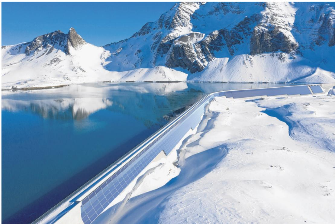
Visualisierung der Solaranlage AlpinSolar an der Muttsee-Staumauer des Pumpspeicherwerks Limmern im Kanton Glarus.
