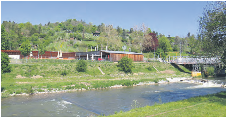
Die Baustelle an der Weilstrasse sollte den Badeplausch nicht beeinträchtigen. Die Hilfsbrücke über die Wiese gewährleiste den Zugang.
