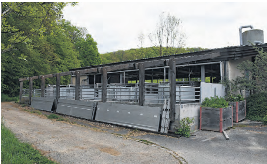
Der alte Schweinestall auf dem Maienbühlhof, der zum Rinderaufzuchtstall umgebaut werden soll.
