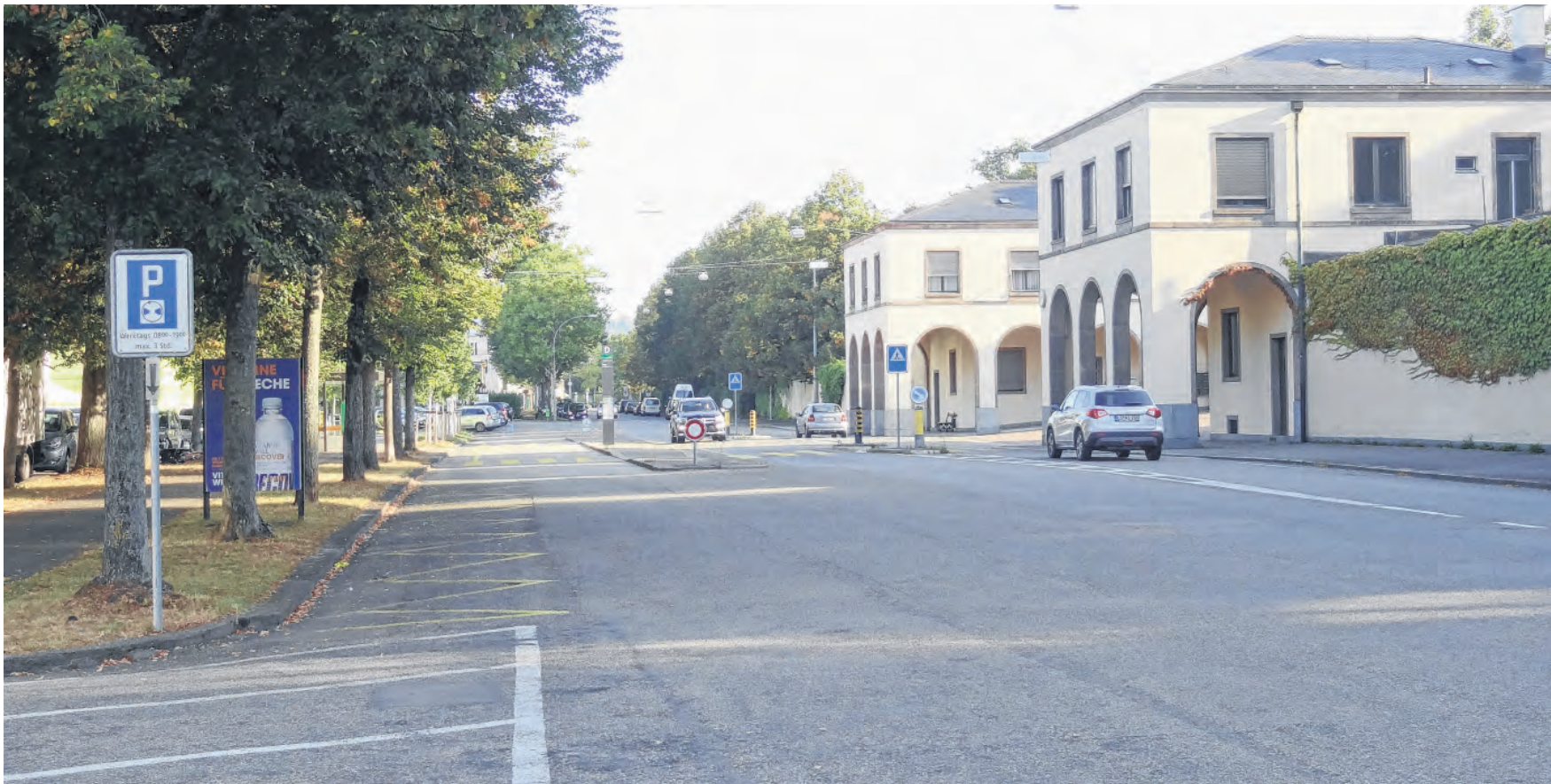
Die Stimmberechtigten von Basel-Stadt entscheiden am 26. September, ob es zur Sanierung und Umgestaltung der Hörnliallee kommt.
