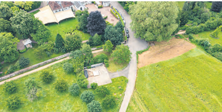
In den kommenden zwei Wochen wird ein Schaden an der Geothermieranlage behoben.
