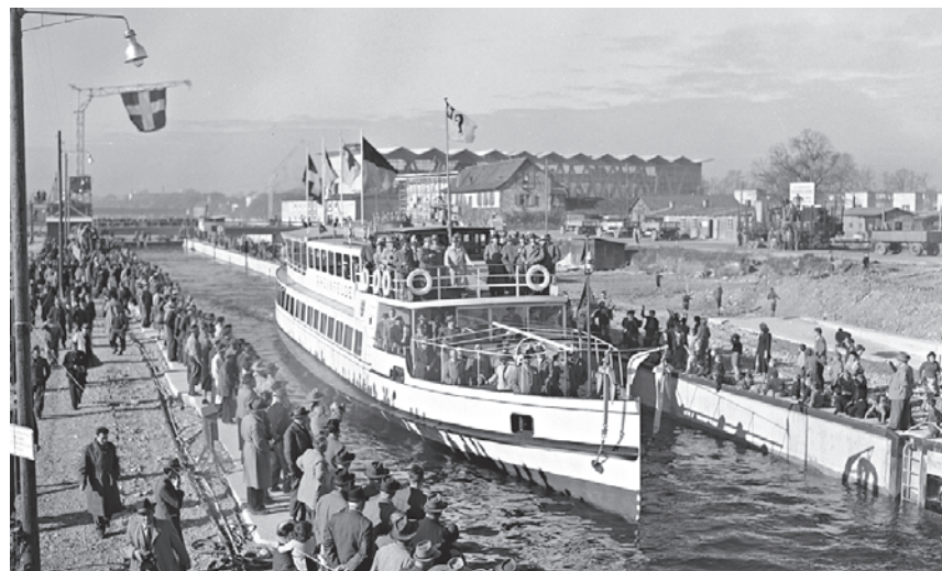
Die MS Rheinfelden passiert am 12. November 1954 als erstes Schiff die neue Schleuse bei Birsfelden.
