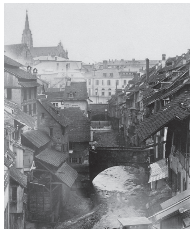
Die «Kloake» des Birsigs vor 1891 in Richtung des Barfüsserplatzes gesehen.
