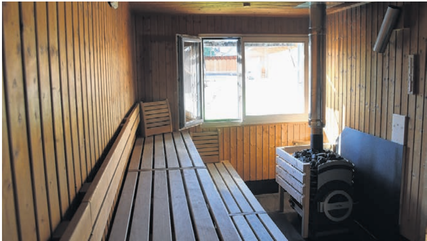
Der neu mit einem Holzofen ausgerüstete Sauna-Container, der bisher in der Sauna am Rhy in der Breite stand, von innen.
