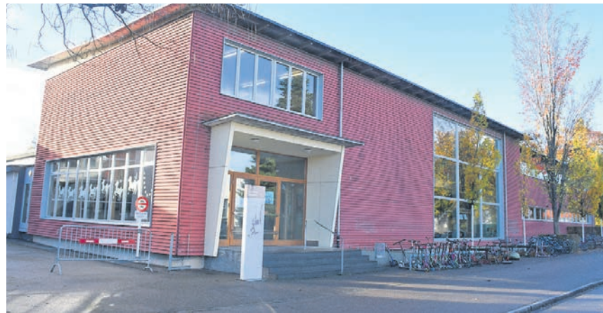
Der Erweiterungsbau des Hebelschulhauses mit dem Eingang am Langenlängeweg.
