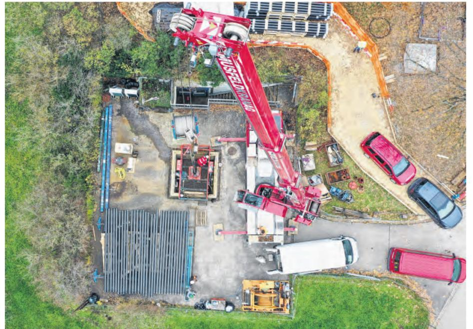
Die Drohnenaufnahme zeigt die Einsetzung der Pumpe ins Bohrloch mithilfe eines Pneukrans.
