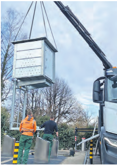
Der Container schwebt in Richtung Boden. Darauf wird der Einwurfbehälter montiert.
