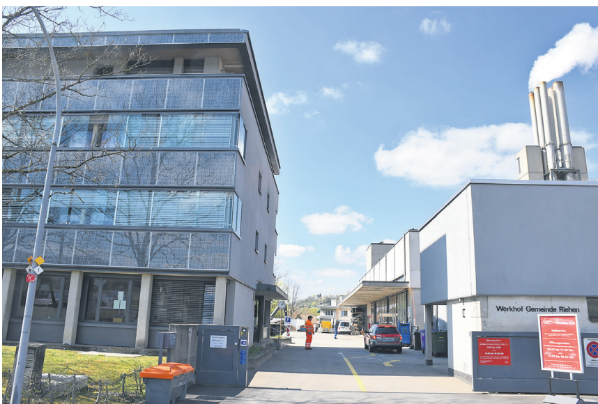
Der Eingang zum Werkhof Riehen am Haselrain.
