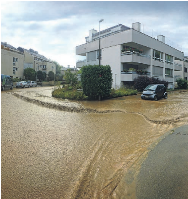
Wasser kommt an der Kreuzung Mohrhaldenstrasse/Immenbachstrasse zusammen. Foto: Dominik Sulzer
