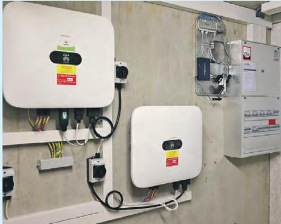
Wechselrichter und Steuerung im Technikraum
