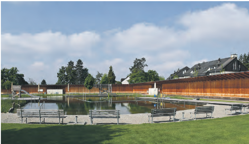
Im Naturbad Riehen, dessen Atmosphäre stark vom omnipräsenten Holz geprägt wird, stehen erste Sanierungen des Holzwerks an.
