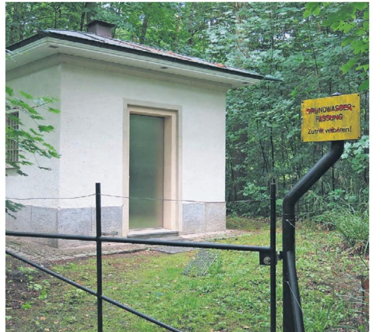
Einer der Grundwasserbrunnen in den Langen Erlen, der das mit dem Grundwasser vermischte Rheinwasser wieder an die Oberfläche pumpt.
