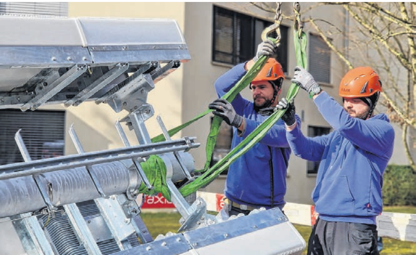
Die Arbeiter prüfen sorgfältig, ob die Antenne gut am Kran befestigt ist.
