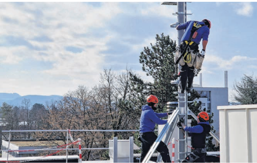
Auf dem Dach wird alles zügig, aber sorgfältig und nach genauen Vorschriften installiert.
