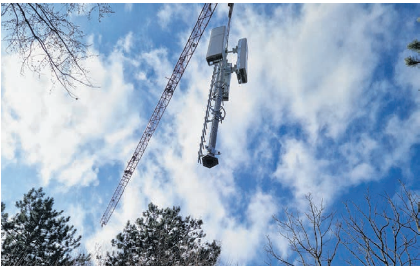
Eine schwebende Antenne sieht man nicht alle Tage: Hier der Mast, kurz bevor er das Dach der Liegenschaft erreicht.
