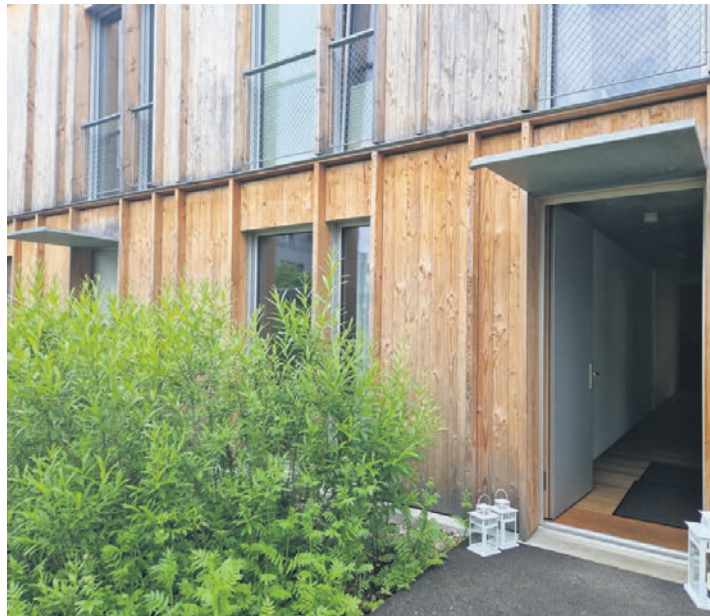
Das grosszügige Grün und die Holzfassade der Atelierwohnungen an der Rebenstrasse sprechen für Naturnähe.
