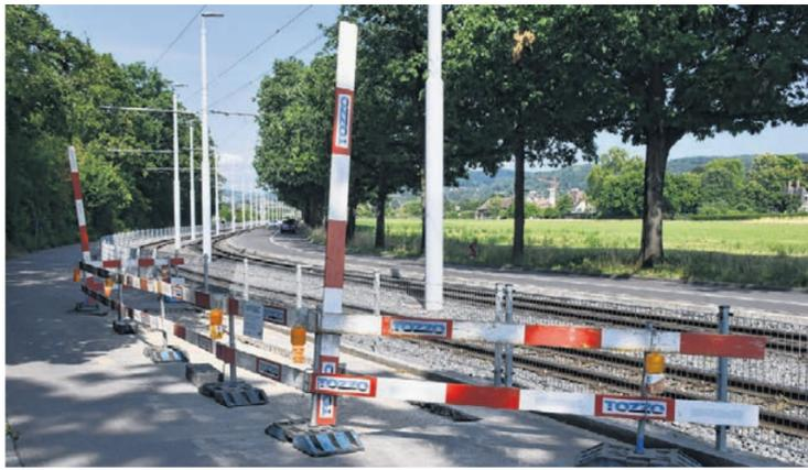
Die schadhafte Stromleitung auf der Nebenfahrbahn der Riehenstrasse nahe der Tramschleife Eglisee ist repariert, der Graben wieder aufgeschüttet, es fehlt noch der Deckbelag.
