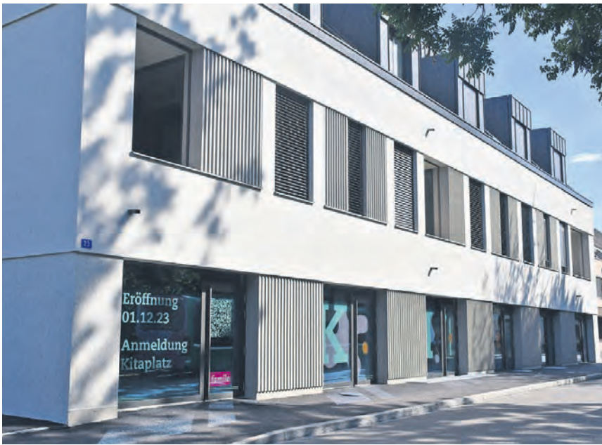
Das frisch sanierte Gebäude an der Bahnhofstrasse 23 nimmt im Erdgeschoss die Kindertagesstätte der Familea auf.
