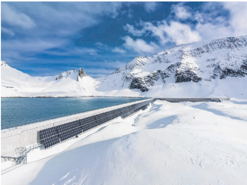
Alpine Solaranlagen wie «AlpinSolar» an der Staumauer des Muttsees liefern dringend benötigten Winterstrom.
