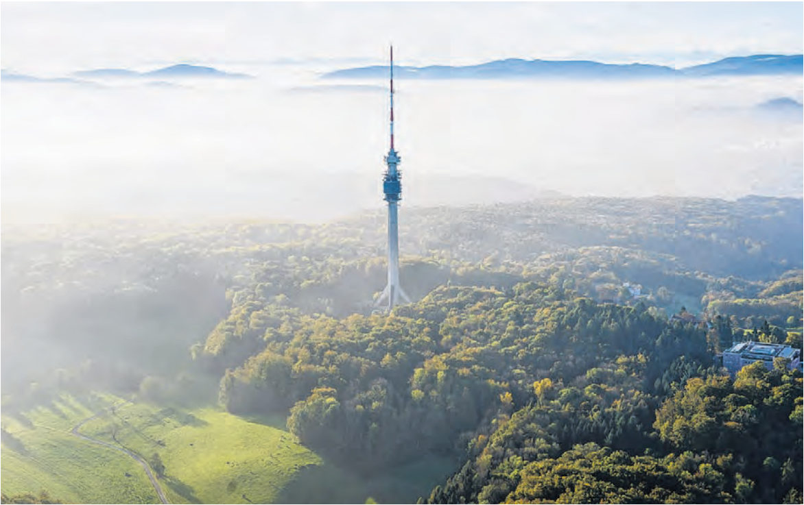
Der 250 Meter hohe Chrischonaturm wurde vor 40 Jahren fertiggestellt und ist ein von weit her sichtbares Wahrzeichen Bettingens. Der erste Sendemast auf St. Chrischona (rechts im Bild) aus dem Jahr 1954 mass 30 immerhin Meter.
