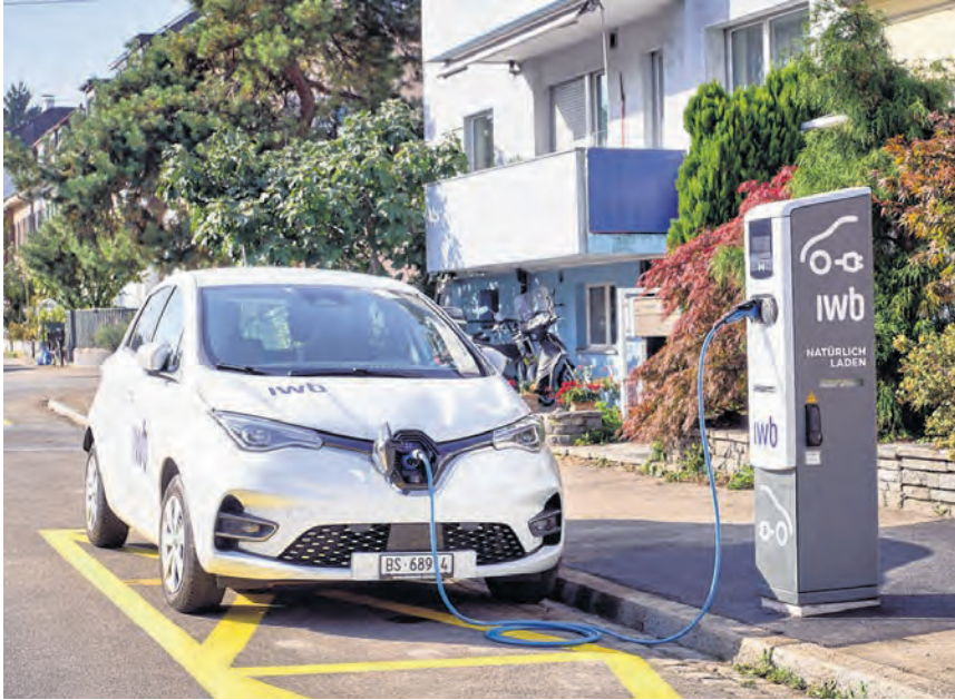
Eine Ladestation der IWB.
