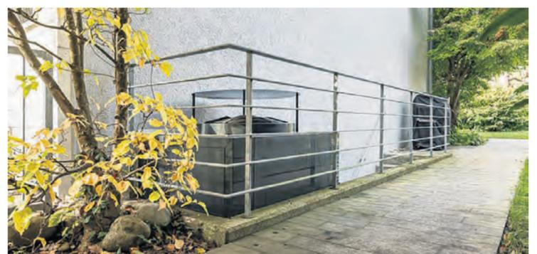
Die Ausseneinheit der Wärmepumpe konnte hier platzsparend über dem Kellereingang angebracht werden.
