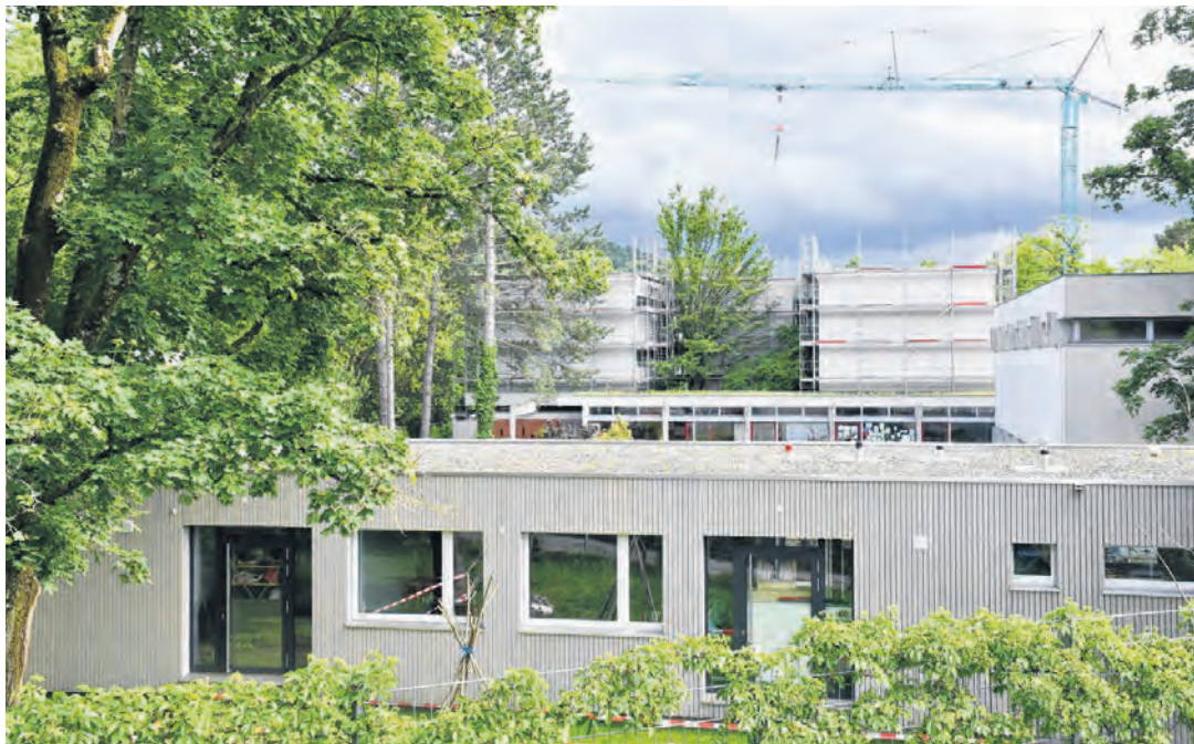
Blick vom Veloweg am Bahndamm auf die Schulbaustelle mit dem Kindergartenprovisorium im Vordergrund und dem Wasserstelzenschulhaus dahinter.
