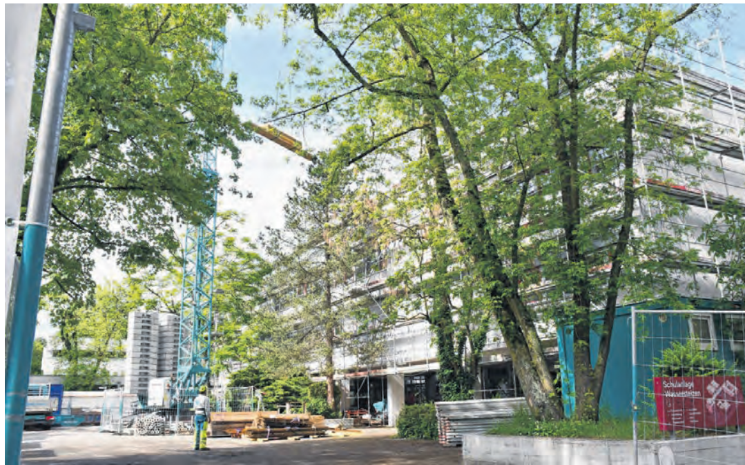
Blick vom Wasserstelzenweg auf die Baustelle mit dem alten Primarschulhaus rechts und dem Turnhallentrakt im Hintergrund.
