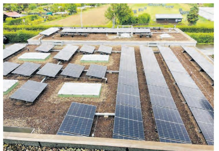
PV-Anlage auf dem Dach des neuen Recyclinghofs sowie dem Nebengebäude mit nach Süden, Osten und Westen ausgerichteten Modulen.
