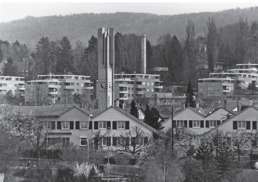
Das um 1978 entstandene Foto zeigt von der Morystrasse her gesehen im Vordergrund mehrere Häuser der Heimstätten-Genossenschaft Gartenfreund, dahinter ist der Turm der Kornfeldkirche zu sehen. Foto: Gemeindecarchiv Riehen
