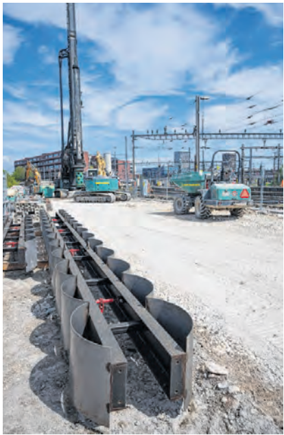
Die Baustelle am Erdbeergraben mit Bohrschablonen.
