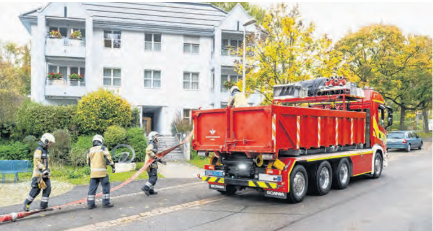
Der Schlauch, der als provisorische Wasserleitung dienen soll, wird vom Verladefahrzeug ausgerollt und auf der Hauptstrasse verlegt.
