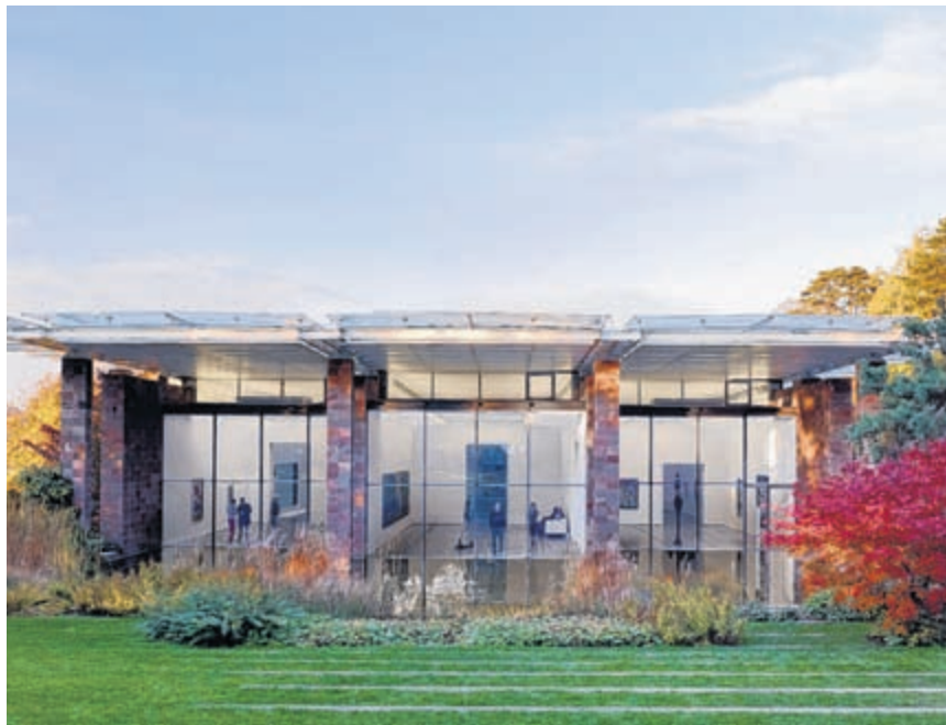
Der Museumsbau der Fondation Beyeler, erbaut von Renzo Piano, von Süden her gesehen. Foto: Mark Niedermann
