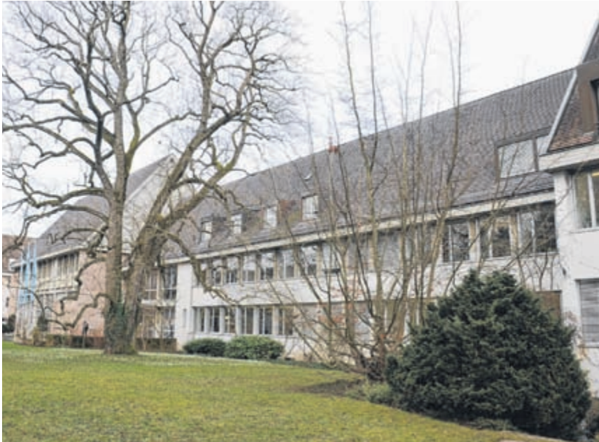
Im Gebäudeteil zwischen dem Saalbau und dem Erweiterungsbau an der Bahnhofstrasse sollen die Fenster ersetzt werden. Foto: Rolf Spriessler-Brander
