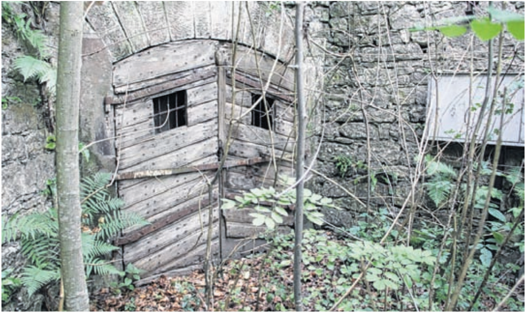
Durch diese Holztüre erreichte man früher einen unterirdischen Bierkeller.
