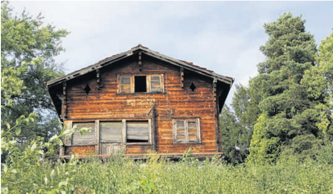
Das Holzgebäude am Hungerbachweg erinnert an das legendäre «Alte Haus von Rocky Docky».
