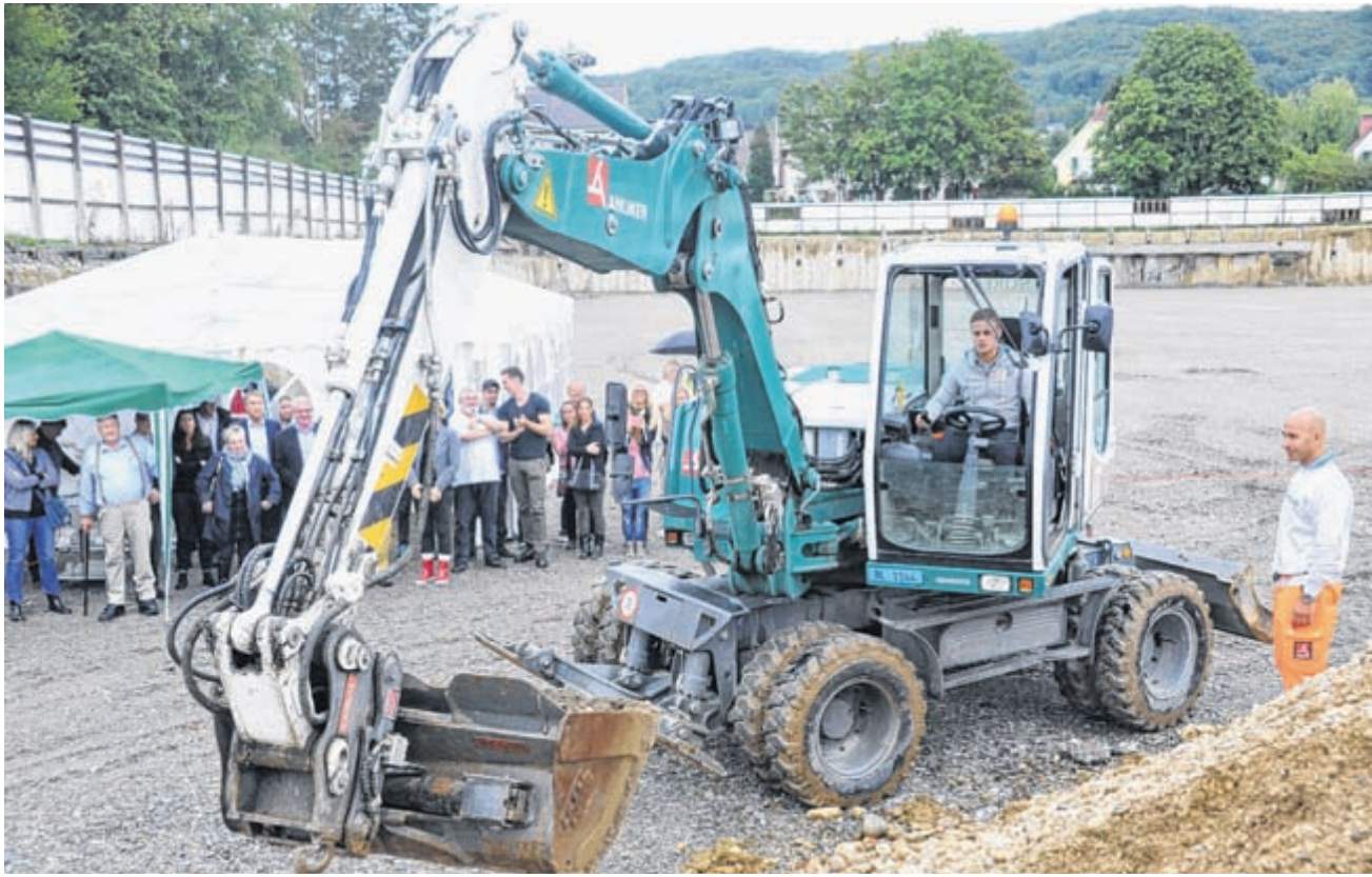
Der WGN-Lehrling Valentin Roos hat sich in den Bagger gesetzt und nimmt, beobachtet von den Gästen beim Festzelt im Hintergrund, den offiziellen Spatenstich vor.
