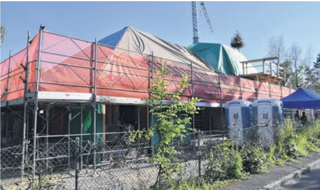
Das neue Kindergartengebäude an der Paradiesstrasse im Rohbau, vom Schulhaus Burgstrasse her gesehen.
