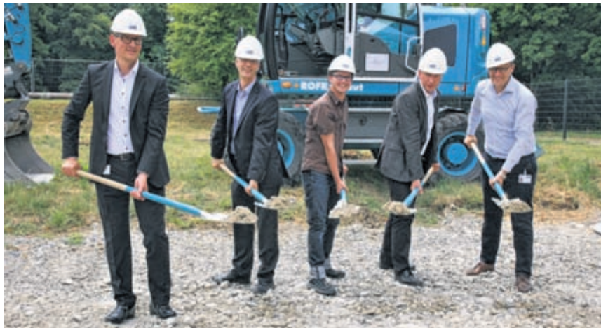
Beim Spatenstich vereint (v.l.): Markus Küng (Leiter Netze), Martin Eschle (Leiter Beschaffung), Stefan Crollet (Planungsingenieur), Thomas Meier (Leiter Produktion Wasser) und Adrian Ambord (Leiter Engineering).
