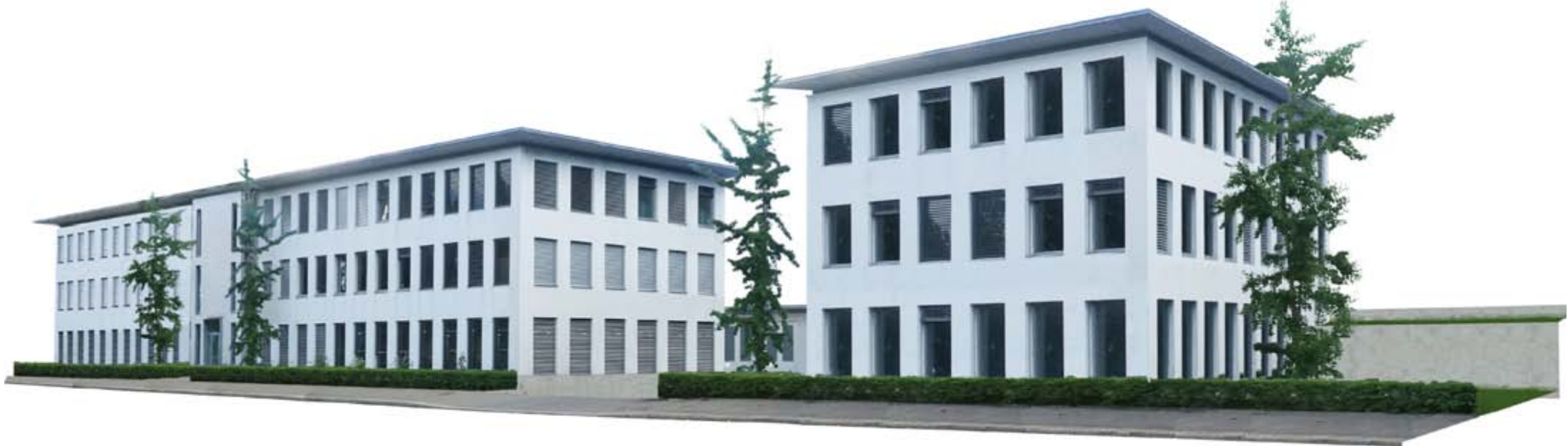
Gegenwart und Zukunft auf einem Bild: links das bestehende Gewerbehausgebäude entlang der Lörracherstrasse, rechts der geplante Neubau auf dem Schwarz-Areal.
