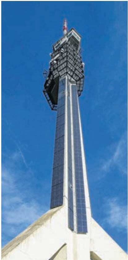
435 Fotovoltaikmodule umhüllen seit Anfang Oktober die Radio- und Fernsehstation St. Chrischona.
