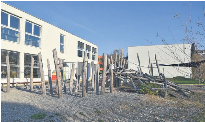
Der Übergang vom Kindergarten in die Primarschule soll durch die Umsetzung eines Konzeptes optimiert werden – Blick auf die Kindergarten- und Schulergänzungsbauten beim Schulhaus Hinter Gärten.
