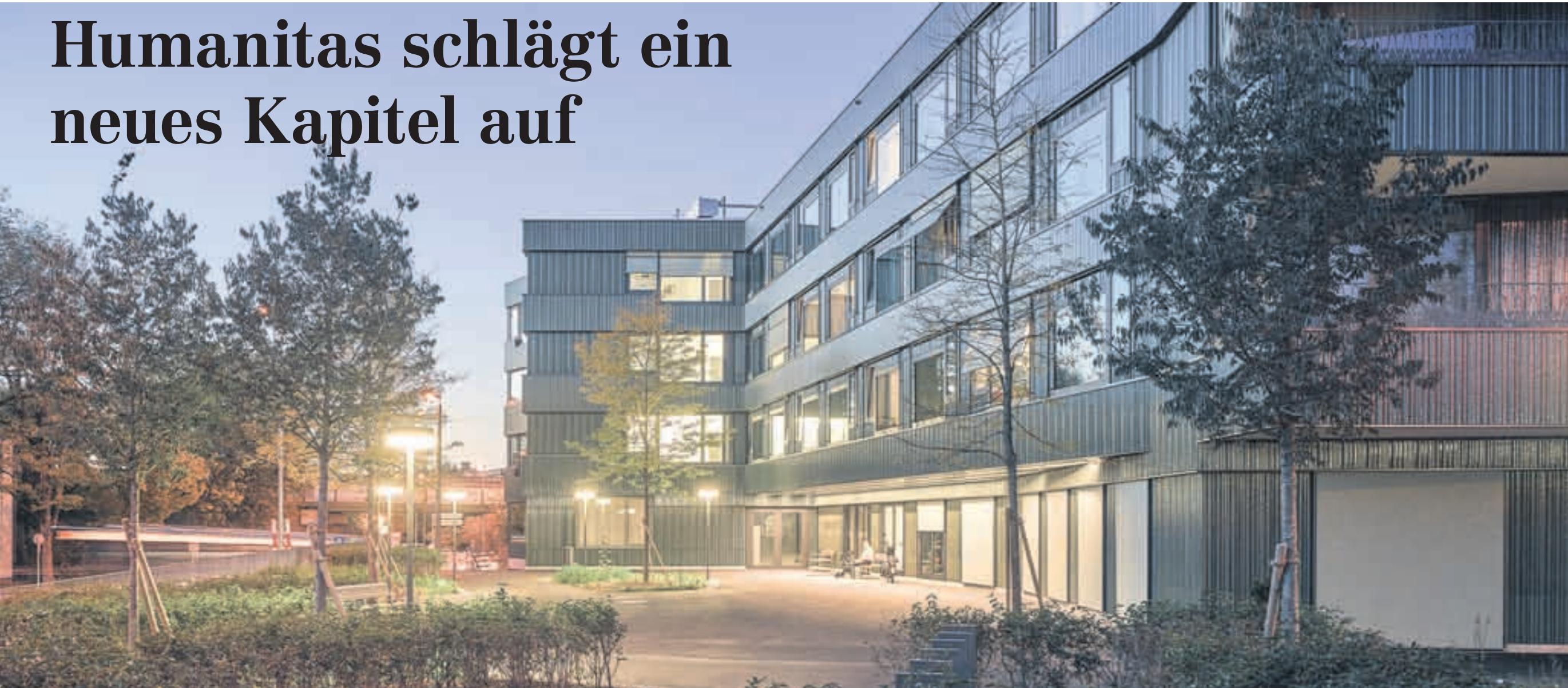
Aussenansicht Humanitas in der Rauracherstrasse in Riehen
