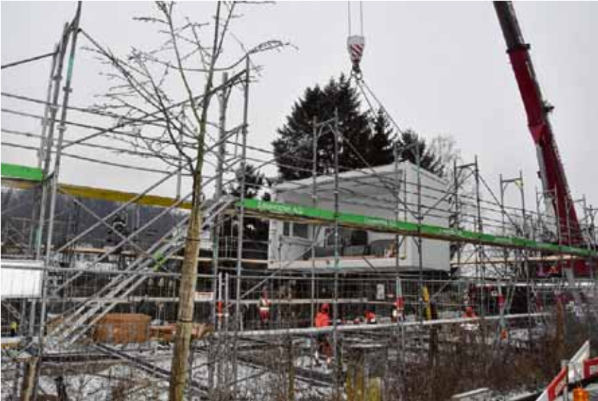
Langsam, aber sicher hievt der Kran das erste Element des provisorischen Schulbaus auf das Fundament (von oben links nach unten rechts). Fotos: Loris Vernarelli
