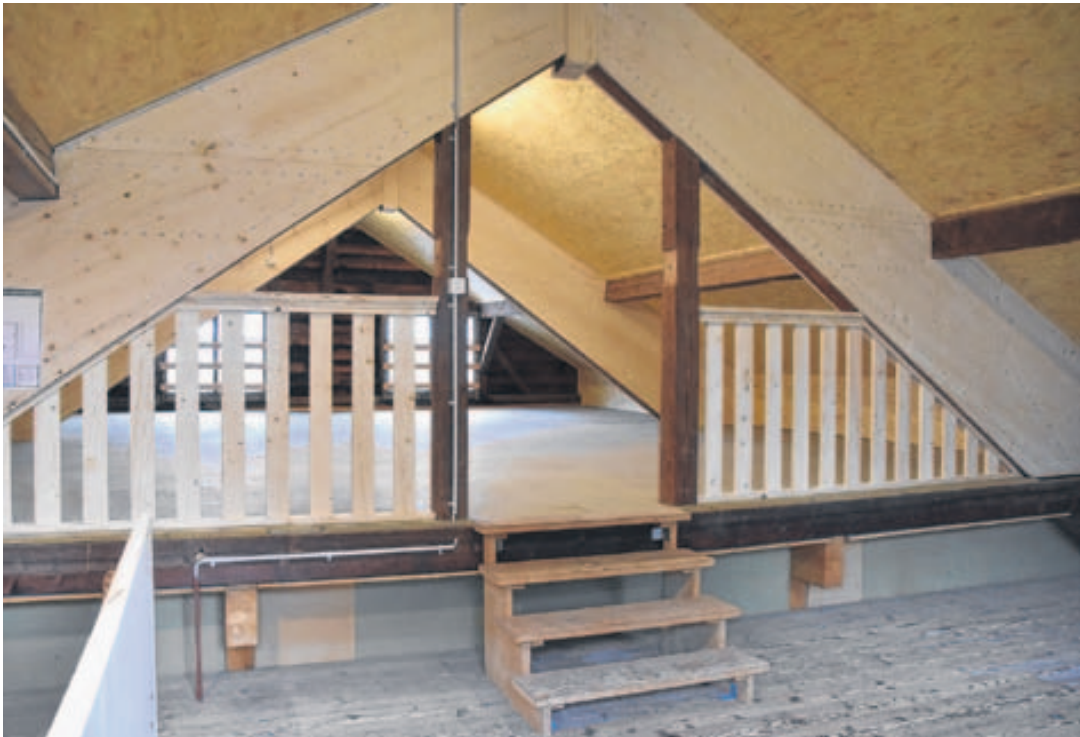
Das Reich der kleineren Kinder: Das geräumige Dachgeschoss des alten Landi-Gebäudes wurde zum Spielestrich ausgebaut.
