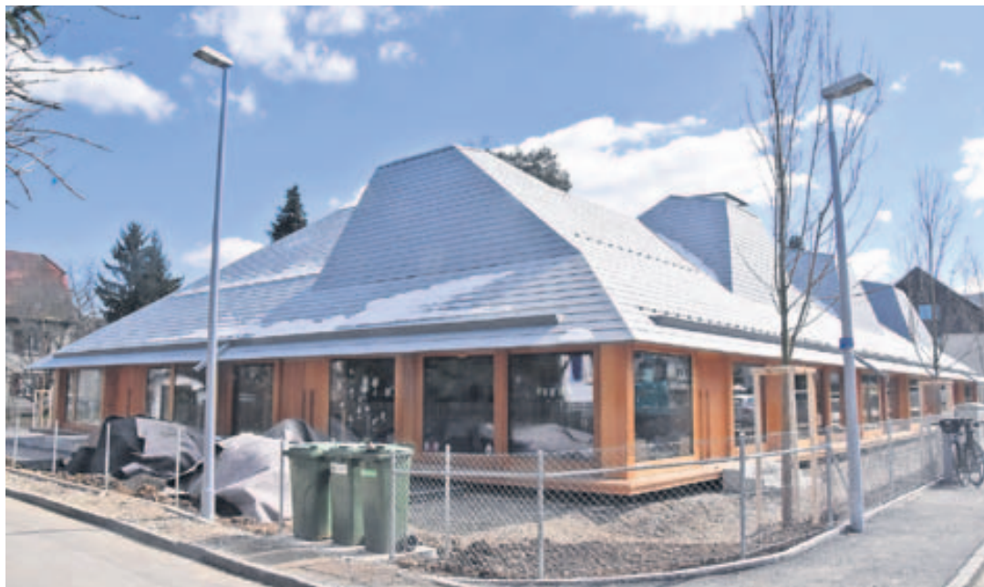
Das neue Pavillonlongebäude von der Paradiesstrasse her gesehen, wo die beiden Kindergärten untergebracht sind.
